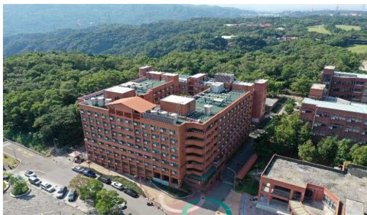
學生二、三期宿舍頂樓防水工。
