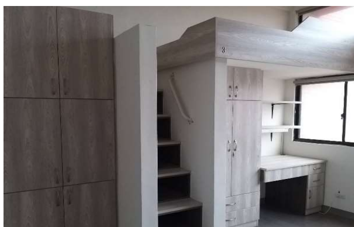
學生一期宿舍內部設施整修工程。
