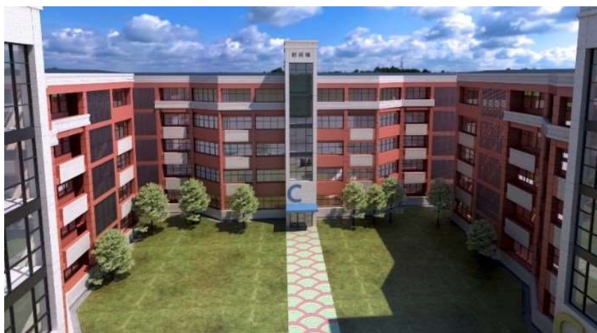
學生一期宿舍外牆防水及門窗更新工程。
